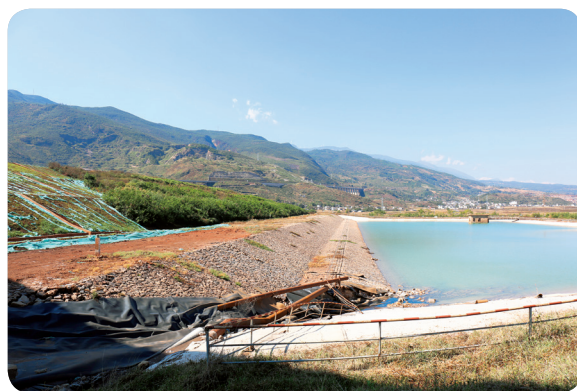
尾矿库调节池主要用于收集尾矿渗透液和库内雨水，通过回水泵房进行回用，图为北衙公司尾矿库调节池
