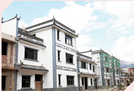
鹤庆县北衙片区整体搬迁县城安置点在建住房
