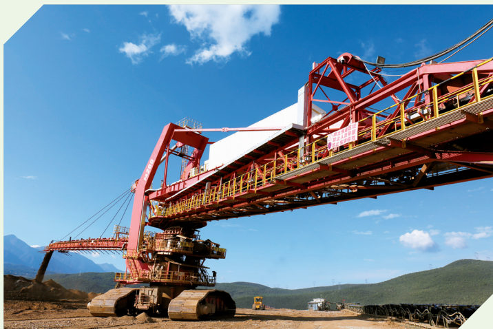
废石通过胶带运输，最终抵达排土机，排入排土场
