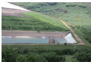
北衙大沙地尾矿库
