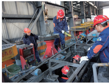
长安金矿开展大检修工作，图为检修工人更换浮选机
