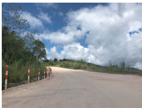
勐满金矿捐资修筑的关河公路矿区路段
