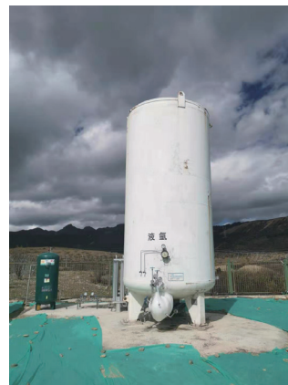
红牛铜矿地处雪域高原,高寒缺氧,为保障员工工作生活,在员工宿舍配备齐全的集中供氧设施
