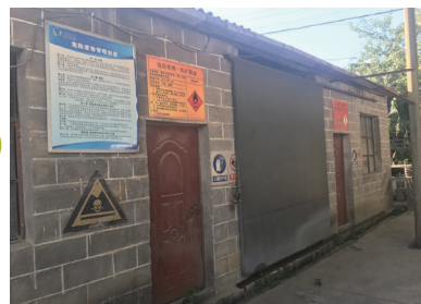
长安金矿危险废物贮存间
