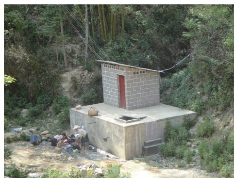
长安金矿资助建设的甘河村小组饮水工程
