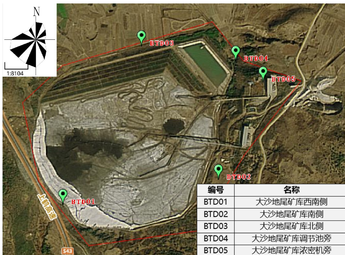
图 6.5 重点监管单位土壤监测点（大沙地尾矿库）
